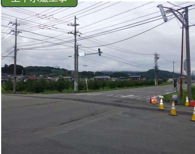
上下水道工事
